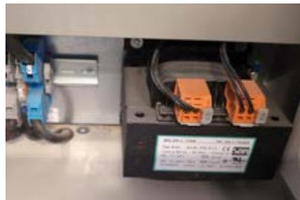
Thyristor Lader sind in der Regel offen montiert im Anlagenschrank und einfach zu erkennen an der typischen Trafo Form.
